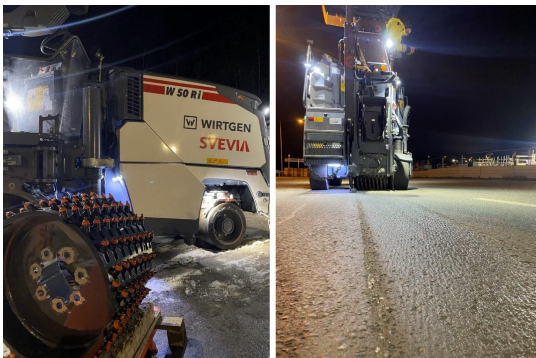
Figur 1 Borttagning av vägmarkering med mekanisk fräsning. Foto: Victor Bergkvist, Svevia.
