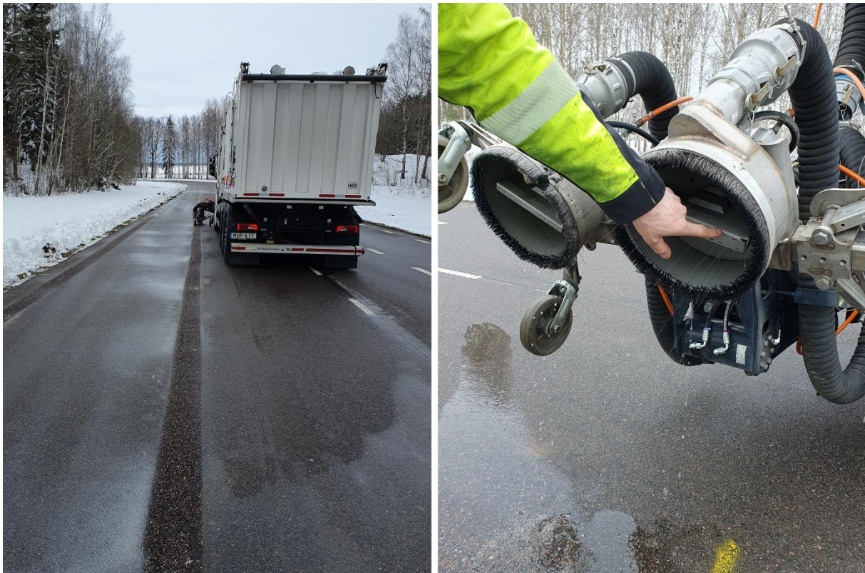
Figur 2 Borttagning av vägmarkering med högtrycksvattenblästring. Foto: Hanna Fager, VTI.
